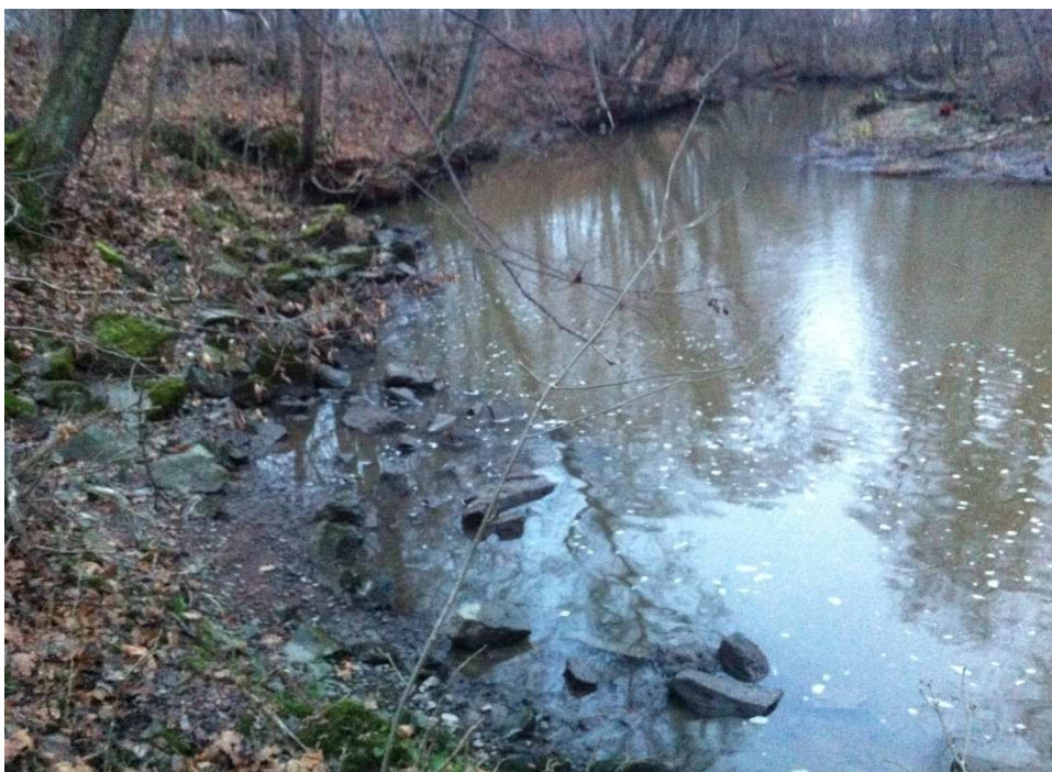
Figur 5 Erosionsskydd i dåligt skick i östra delen av området, Lärjeåns krök intill spårvägen
